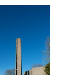
Beffroi en béton banché et vibré
